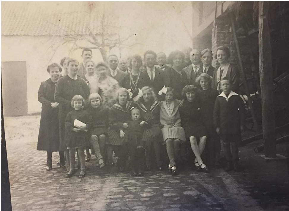
Figuur 25 Een foto van de familie Sneyders gemaakt vanuit de toegangspoort van hoeve De Bleuke in Kortenaken uit het einde van de negentiende eeuw. Aan de hand van deze foto kan afgeleid worden dat er in die periode linksachter een witgekalkte, lemen schuur stond. Deze schuur is reeds lange tijd afgebroken en vervangen door een grotere, bakstenen schuur, die tegenwoordig rechts staat.
