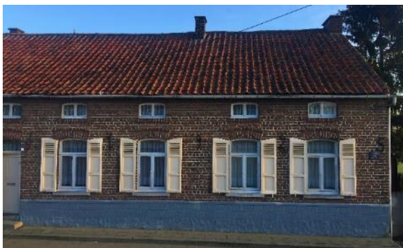
Figuur 19 Muurankers op de gevel van de hoeve van Teske in Kortenaken vormen het jaartal 1925. De eeuwenoude hoeve kreeg toen haar bakstenen buitenschil.
