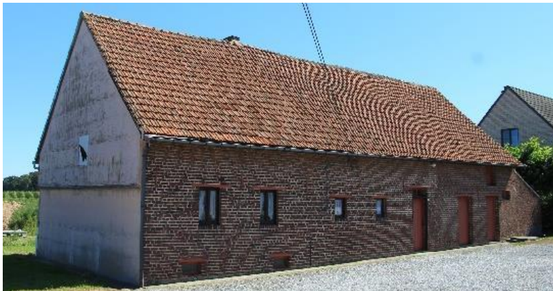
Figuur 15 Deze langgestrekte hoeve op de Leedsevroente 10 in Kortenaak is vandaag verdwenen. Links lag het woonhuis, in het midden de koeienstal en rechts twee varkensstallen. Boven hun lage plafond kon via een luik de oogst opgeslagen worden.
