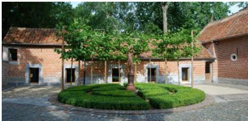
Figuur 17 De hoevegebouwen van het Monnikenhof van Vlierbeek in Geetbets zijn gerenoveerd tot feestzaal- en ontvangstruimten. De voormalige varkensstallen zijn uitgebroken tot één ruimte. De lage vensteropeningen die opeenvolgend uitgeven op de koer verraden echter hun voormalige functie als deuren van de afzonderlijke varkensstallen.
