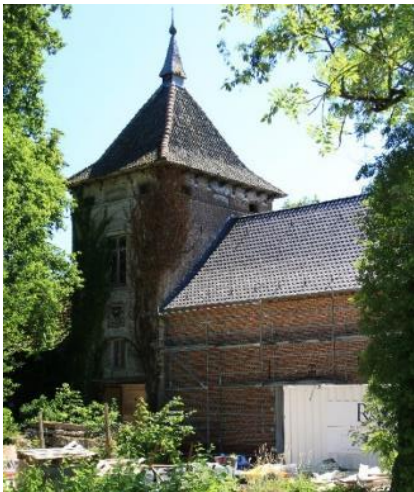
Figuur 11 De poorttoren van de hoeve van Hogemeyer in Kersbeek-Miskom telt 4 bouwlagen. Het draagt bovendien het wapenschild van de 19 e -eeuwse eigenaars: de Turck de Kersbeek.
