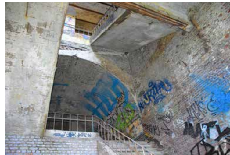
Fig.21: Trappenhuis aan de verbinding tussen twee kazernegebouwen. © David Maes Simon Stevin V.V.C.
