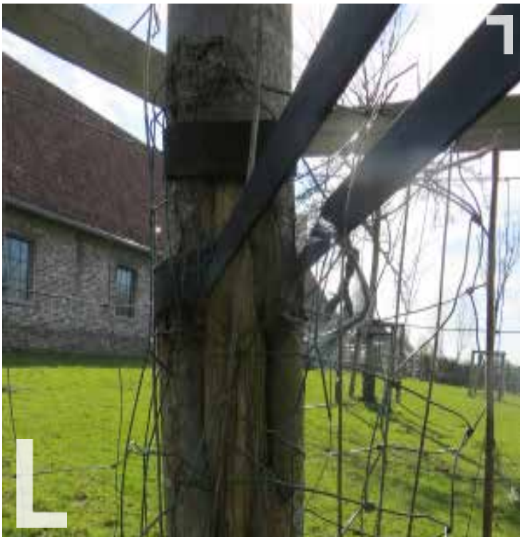
Slecht voorbeeld: vraatschade en verwaarlozing van boombescherming
