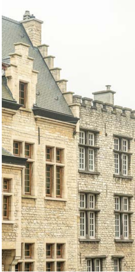
Van plint tot hele gevel, in Zaventem staan gebouwen met kalkzandsteen uit verschillende periodes.
